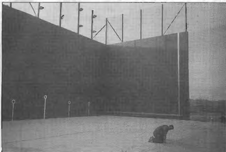
Obras nuevo Frontón
