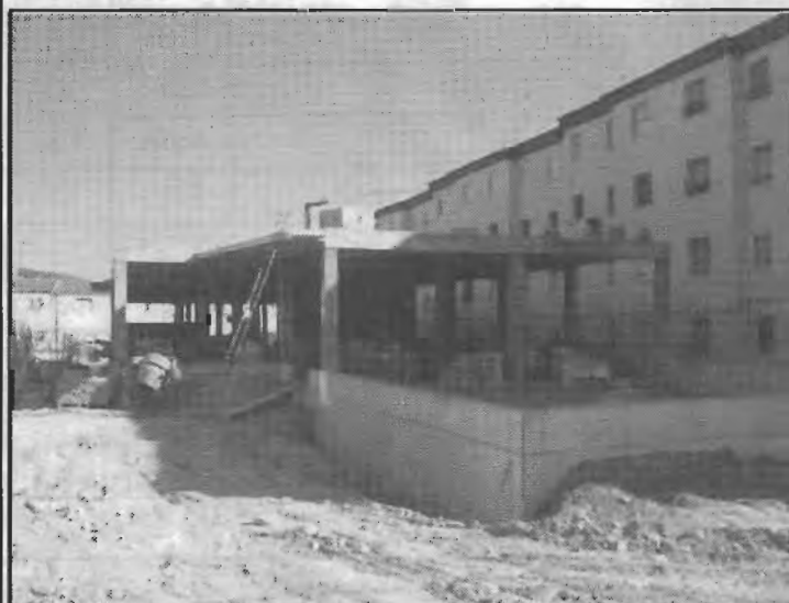
Obras del nuevo Centro
